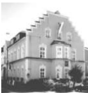
Ehemaliges Spitalgebäude, heute Sitz von Bibliothek und Archiv (Foto: Stadtarchiv Cham)
